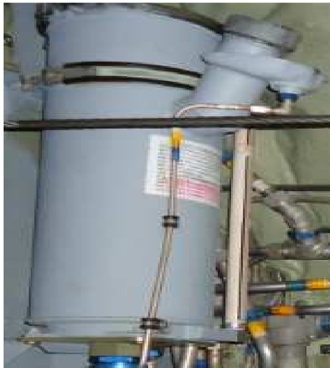
Figura 2.2.7 Depósito del Sistema Hidráulico Utilidad Fuente: Avión FAE 892 C - 130 Elaborado por: Muñoz William
