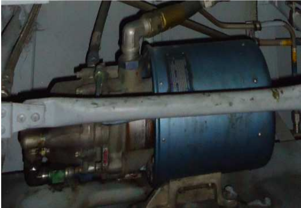
Figura 2.4.3 Bomba actuada por motor eléctrico Fuente: Avión FAE 892 C - 130 Elaborado por: Muñoz William
