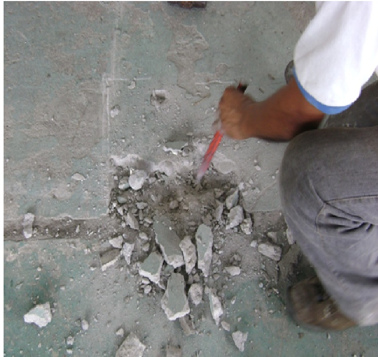
Figura 3.53: Adecuación del suelo para posicionar las bases.
