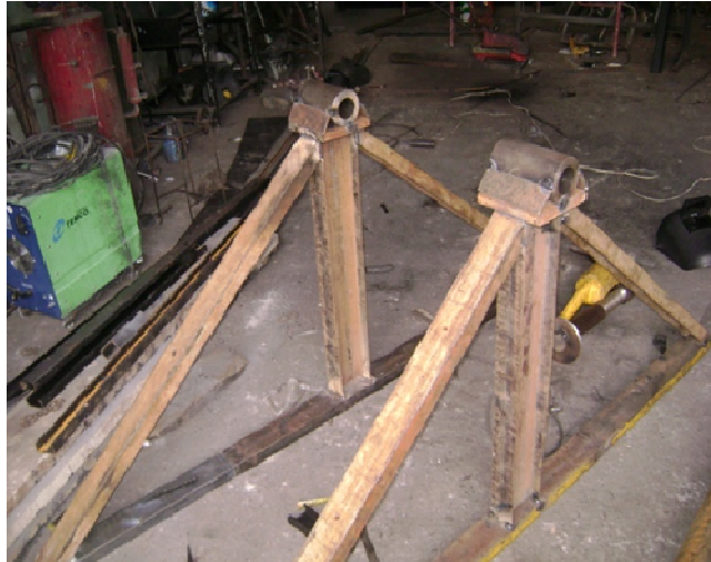
Figura 3.46: Bases laterales terminadas.
