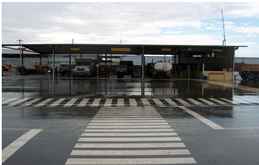
Imagen 2.1: Fotografía Vista frontal Área de Mantenimiento GTA
