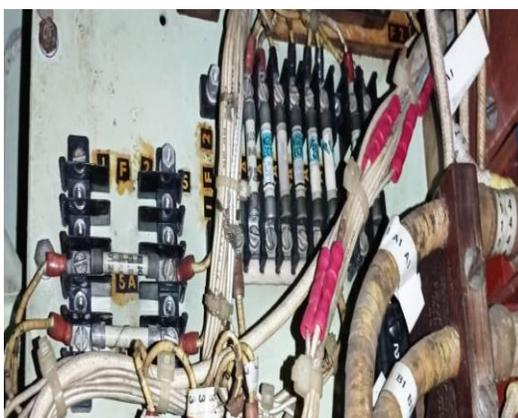
*Nota.* El tamaño de los terminales debe ir acorde al tamaño del cable en donde van a ser instalados para evitar dañar el terminal o los cables eléctricos.
