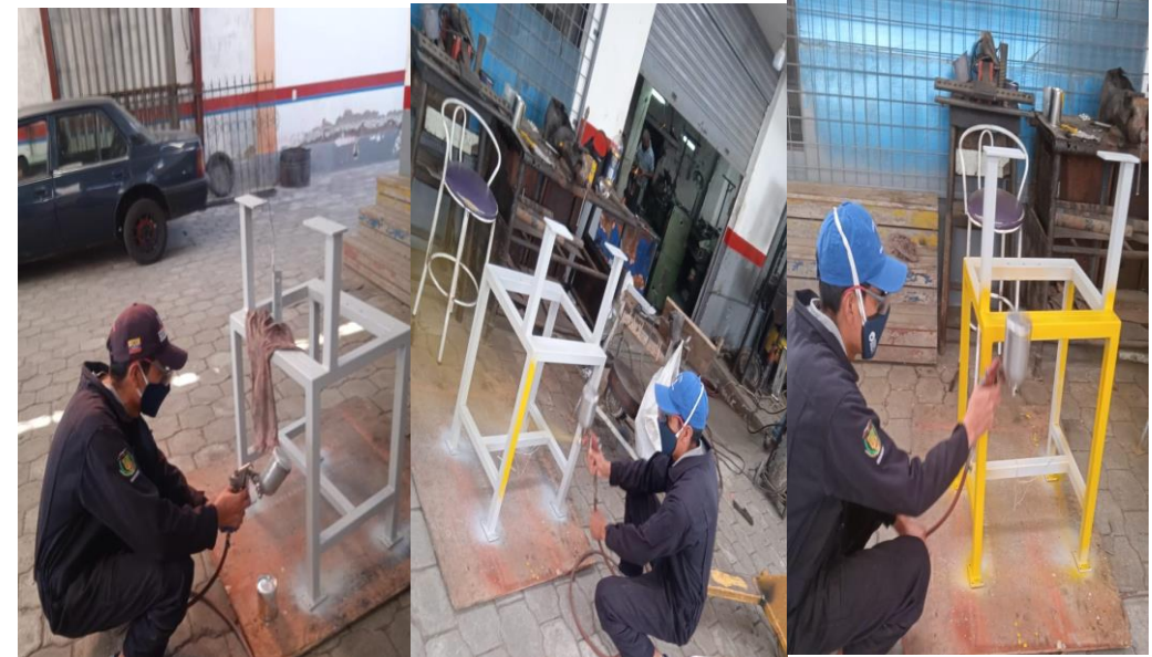
Nota. Se muestra el proceso de pintado del banco de soporte, desde la aplicación del “primer” de fondo protector del acero para que no se oxide hasta el pintado total.
