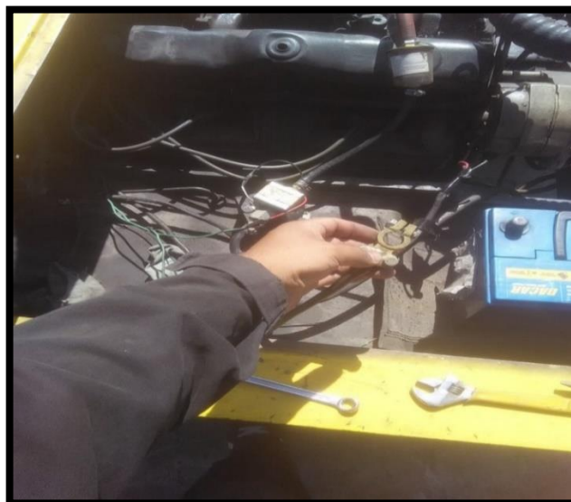
Figura 66 Instalación del Sistema Eléctrico Fuente Propia
