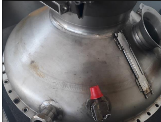
Figura 68 Verificación de los cárteres
