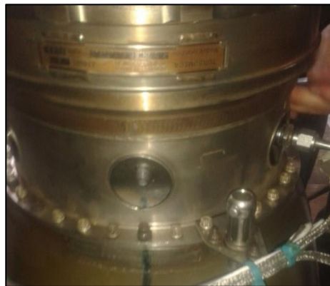
Figura 73 Suelda del módulo 04
