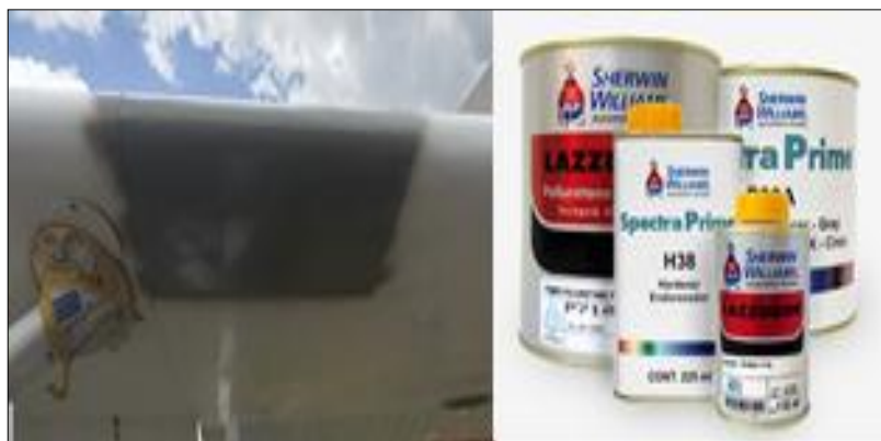
Figura 26 Aplicación del Primer
