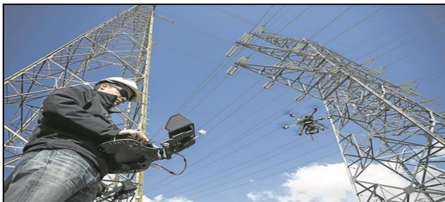
Figura 10. Inspección mediante un drone. Fuente: (Lucas, 2016)
