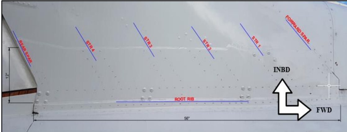
Figura 83. Reparación estructural en el estabilizador vertical LH.
