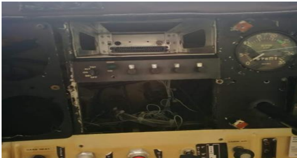
Figura 22. Rack o caja de radio Bendix king
