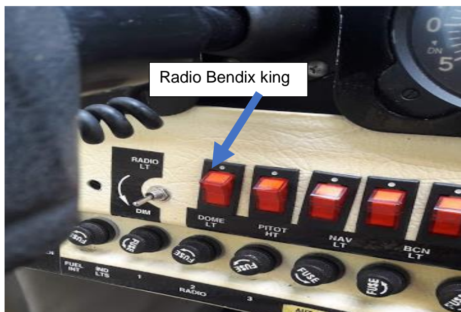
Figura 20. Protección de equipos mediante Fusibles
