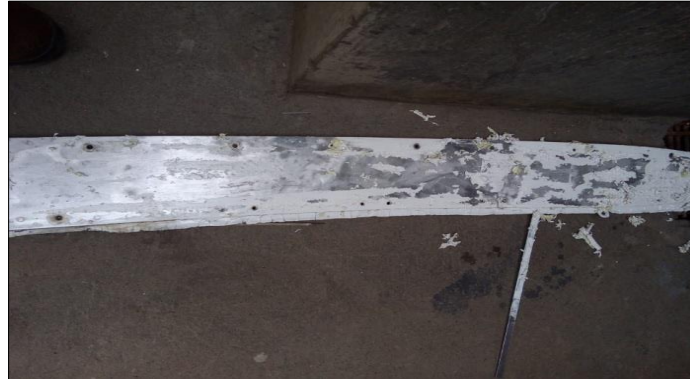
Figura 46. Eliminación de la pintura.
