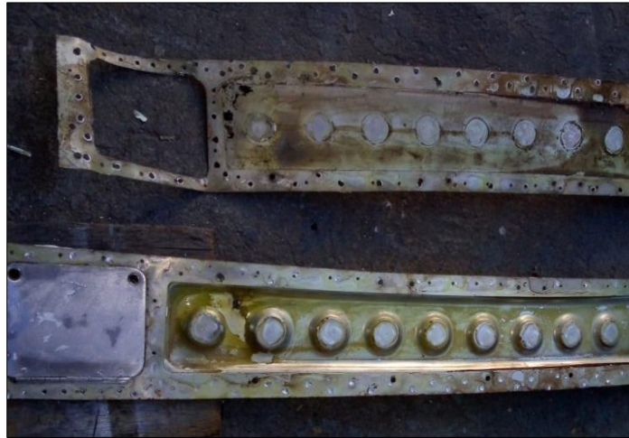
Figura 49. Inspección entre láminas.
