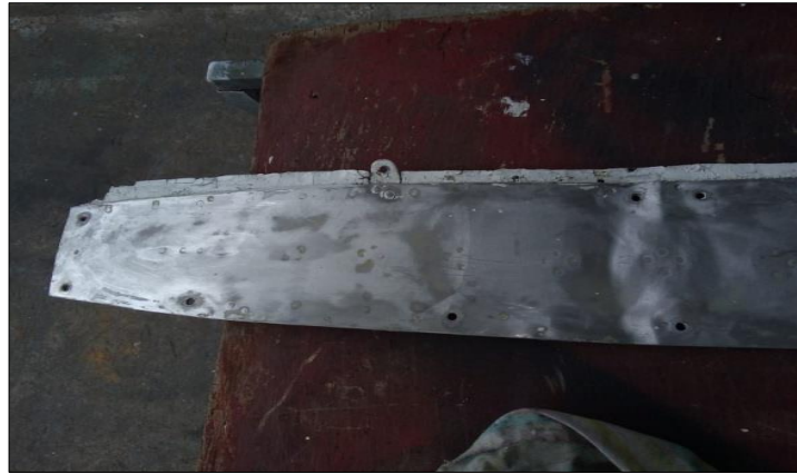
Figura 47. Cubierta libre de pintura.
