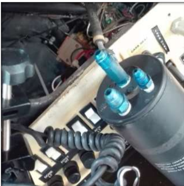
Figura 37 Inspección de los acoples del Horizonte artificial
