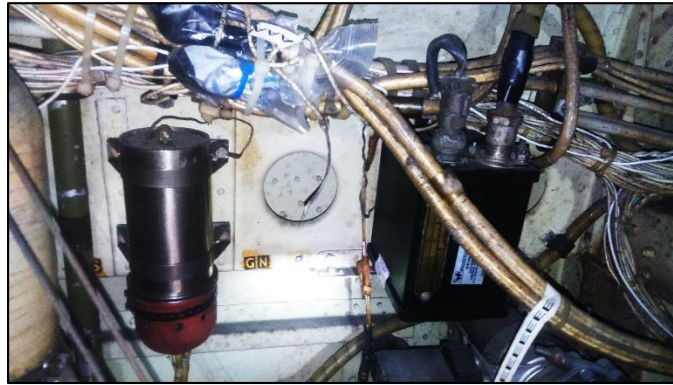
Figura 56 Desmontaje de la caja de alta tensión
