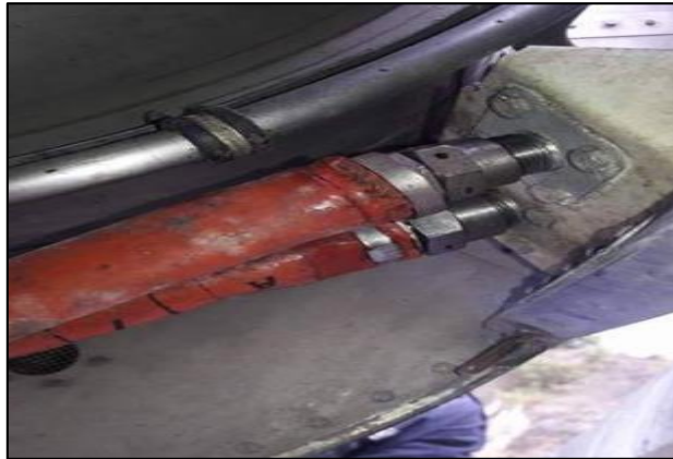
Figura 37 Cañerías del sistema hidráulico
