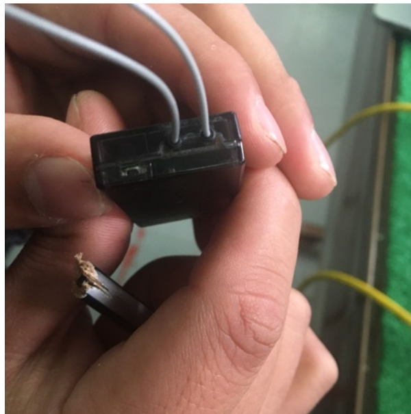
Figura 29 Switch de enlace
