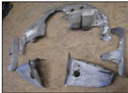
Figura 30.- Remoción de los deflectores deteriorados
