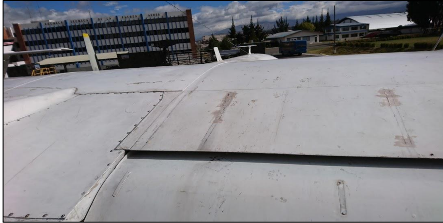
Figura 43 Inspección visual del ala
