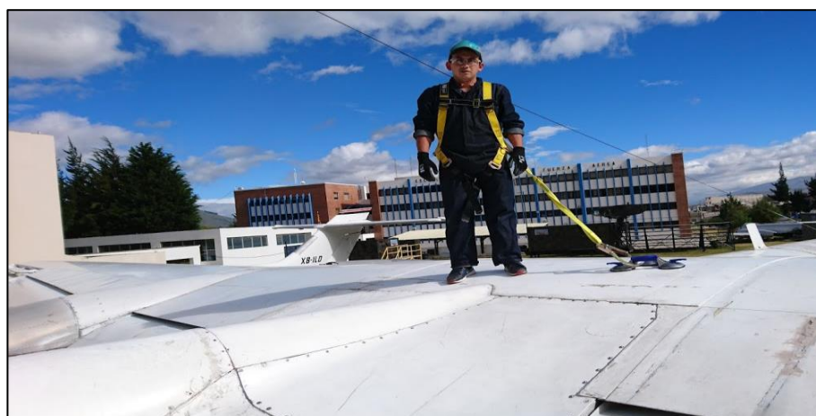
Figura 52 Instalación del equipo de seguridad.
