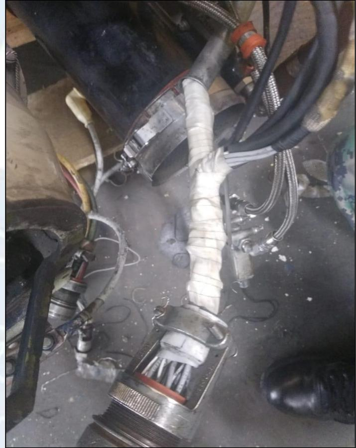
Colocación de la cinta de alta temperatura a lo largo de los cables de alimentación, por encontrarse en condiciones severas, evitando que el daño se extienda.
