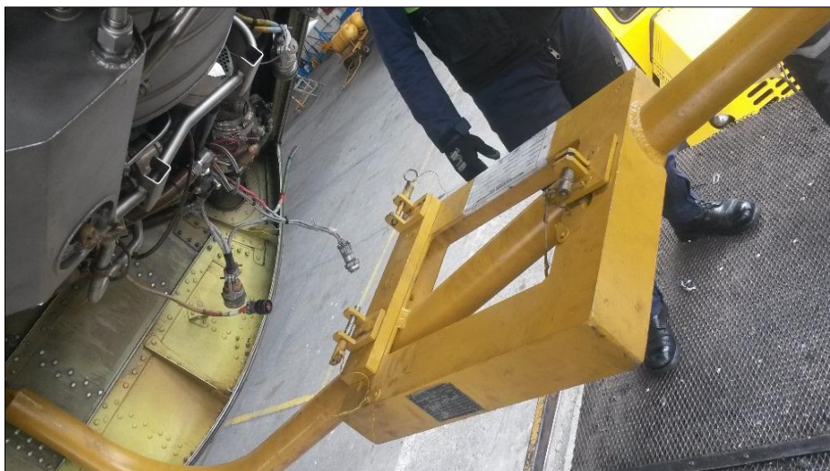
Figura 63 Retiramiento de la base del APU
