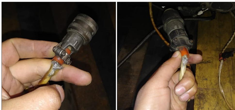
Figura 54 Deterioro de la protección de EWIS
