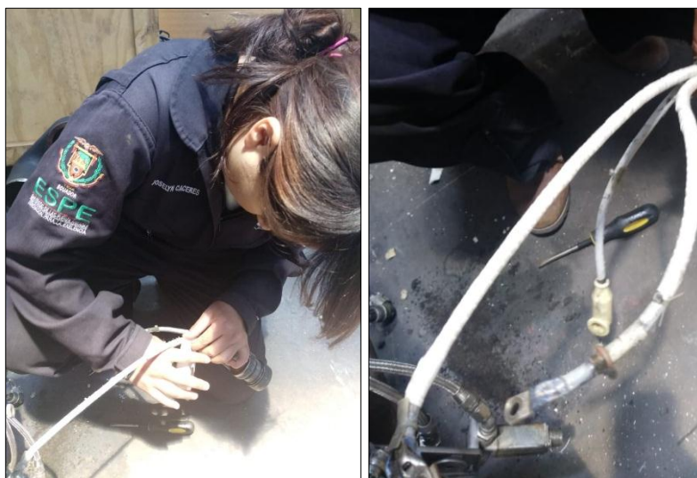
Figura 56 Reparación de los daños en los cables
