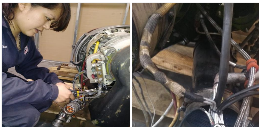
Figura 58 Amarres requeridos en los cables
