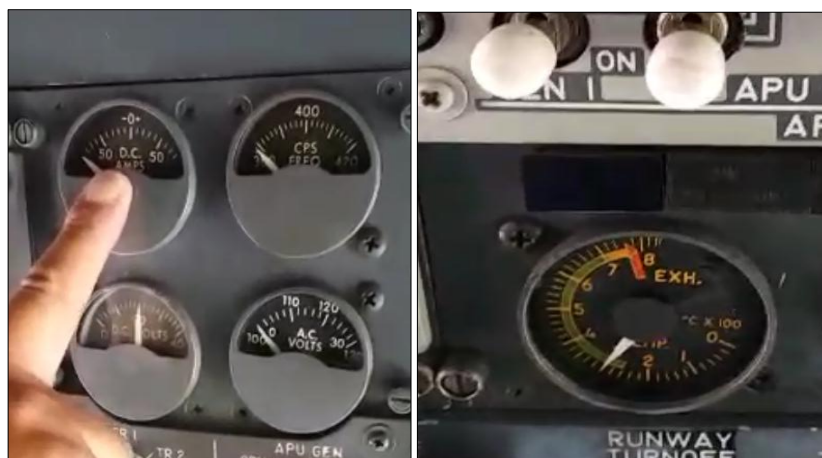
Figura 70 Comprobación de funcionamiento del APU
