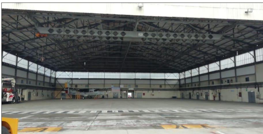
Figura 33 Hangar del Centro de Mantenimiento N°11
