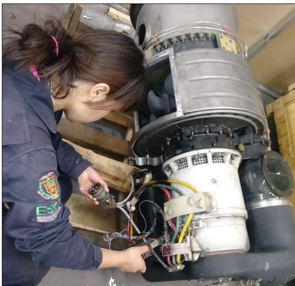
Figura 49 Verificación de existencia de polvo
