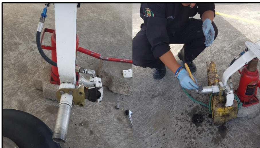
Figura 45 Limpieza interna del tren principal
