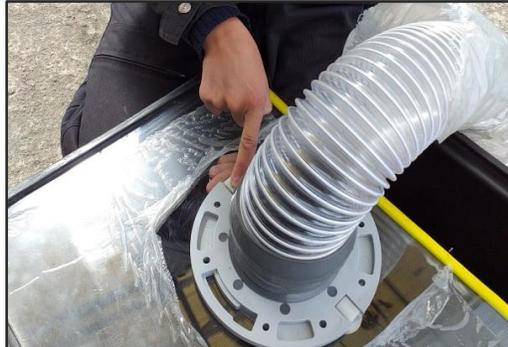
*Nota:* La imagen muestra cómo fue colocada la manguera de plástico y alambre de color blanco en la brida con dos sujetadores tipo abrazadera con tornillo que brindan firmeza y funcionan como selladores entre estos dos espacios.
