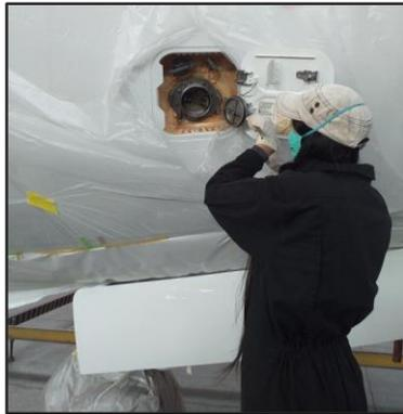
*Nota:* La figura muestra cómo se procedió con las medidas de seguridad de la empresa a cerrar la válvula en la prueba, para continuar con el procedimiento de Prueba de fugas en cada puerto de la aeronave.
