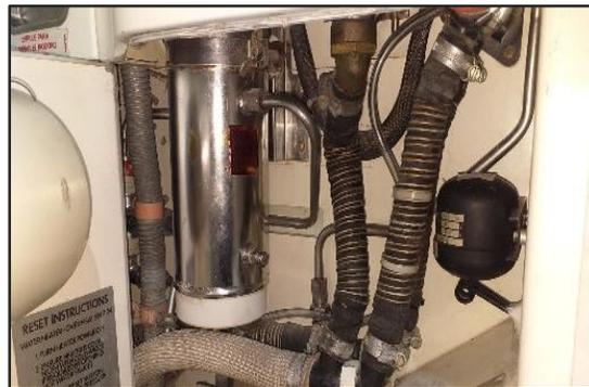
*Nota:* Se muestran los elementos debajo del lavabo, como son el calentador de agua en color plateado al lado izquierdo, una botella extintora de color negro en el lado derecho y una llave de paso para el drenaje de los lavabos.
