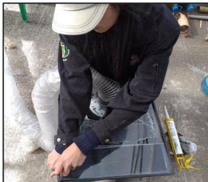
*Nota:* La figura muestra cómo se instaló el acrílico de 5 milímetros en la parte restante con el objetivo de ser reforzada la junta entre las dos láminas, proporcionando un sellado hermético.
