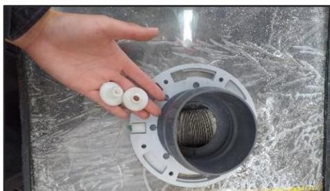
Nota: La figura nos muestra cuales fueron las tuercas con las que se realizó el ajuste de la brida de plástico.
