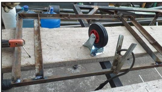
*Nota:* En la figura se exhibe como se realizaron los puntos de suelda guiándose en las llantas y el espacio que debe tener para ser instaladas con el avance del proyecto.
