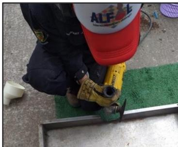
*Nota:* En la imagen se manifiesta la forma que tiene el desagüe y como se realizó el corte en la lámina de acero inoxidable, con la ayuda de una amoladora eléctrica y un disco de corte para metal.
