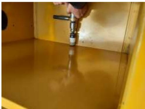
*Nota. Perforación del artefacto para el paso de las tuberías. Creación propia.*
