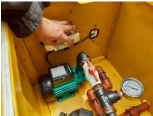
*Nota. Encendido de la bomba a través del disyuntor termo-magnético. Creación propia.*
