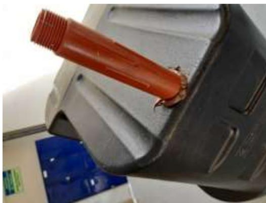
*Nota. Colocación de sellante “permatex” alrededor de la unión de la tubería con el tanque de agua. Creación propia.*
