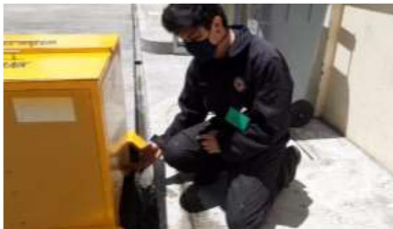
*Nota. Para evitar que quede agua estancada se realizó el drenado del tanque de agua.*
