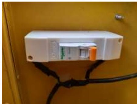
*Nota. Montaje del disyuntor termo-magnético junto con el protector plástico. Creación propia.*
