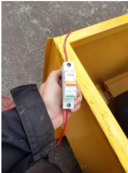
*Nota. Se conectó dos cables de 14 AWG (arriba y abajo) para tener una conexión más segura. Creación propia.*
