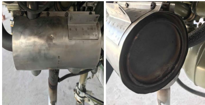
Figura 70 Inspección del sistema de escape
