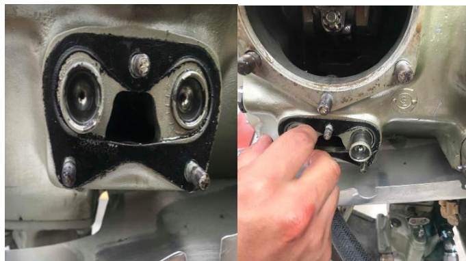
Figura 83 Limpieza e Inspección de los Busos Hidráulicos
