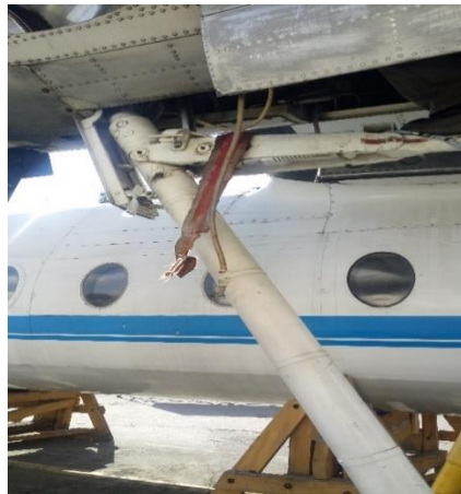
Figura 25. Inspección visual de los elementos.
