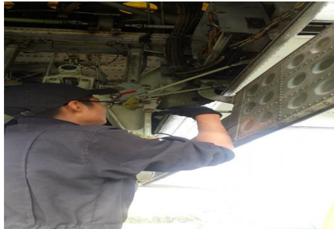
Figura 34. Inspección de las barras de sujeción.
