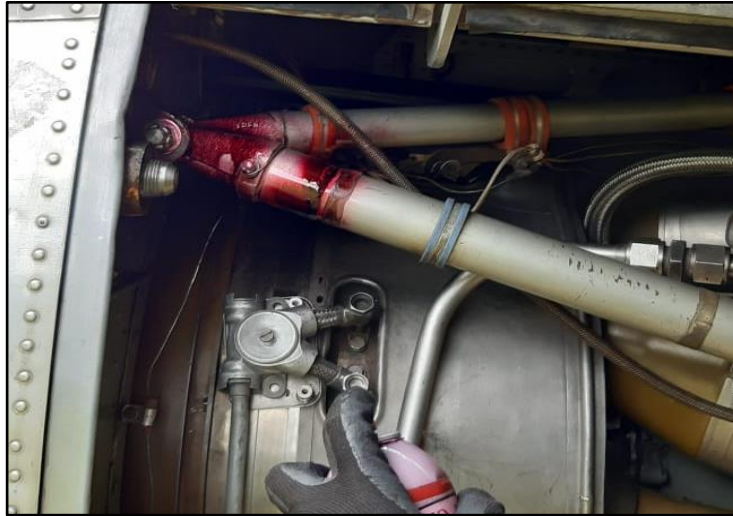
Figura 87. Tinte penetrante al montante superior izquierdo.
