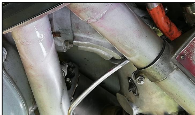
Figura 78. Tinte revelador en el tubo estructural
