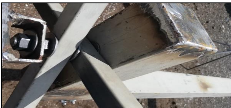
Figura 64. Unión de la viga con el acordeón.
