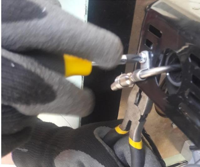
D. Ajuste con firmeza la tuerca para evitar que la termocupla caiga producto de la vibración.
