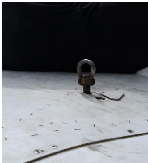
Figura 66: Soportes de izaje de las alas
