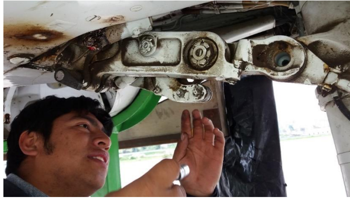
Figura 62:Desinstalación de los pernos del brazo articulado del tren de aterrizaje principal
