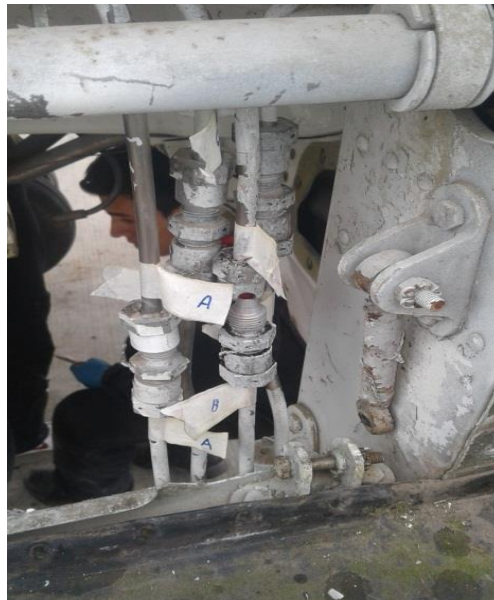
Figura 53: Identificación de las cañerías hidráulicas
