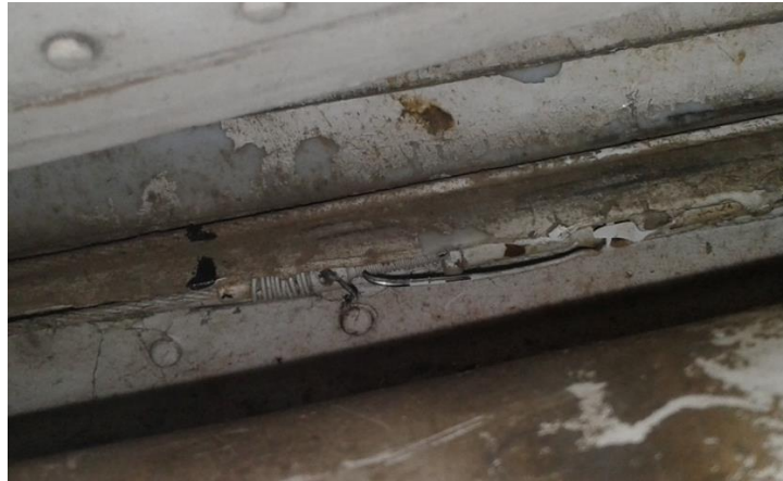
Figura 57: Corte del alambre de freno de los turnbuckles de los cables
