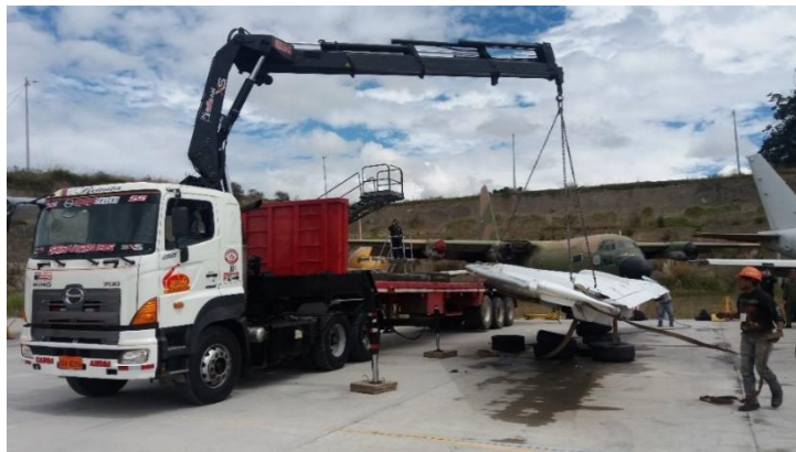
Figura 72:Elevación de las alas con la grúa
