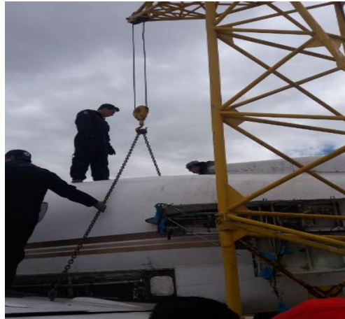
Figura 67:Acoplamiento del tecle a la cadena
