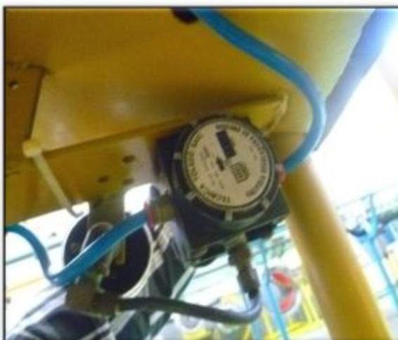
**Figura 60** Instalación del manómetro, válvula reguladora
