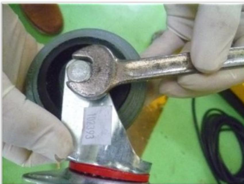
**Figura 69** Cambio de llantas de la estructura metálica
