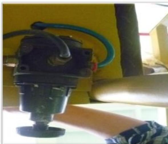
**Figura 59** Instalación de la válvula reguladora de presión
