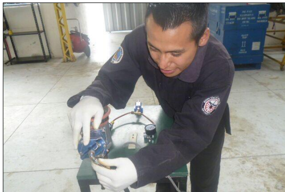
Figura 43 Instalación de la línea flexible al sistema de mando de la válvula de descarga.
