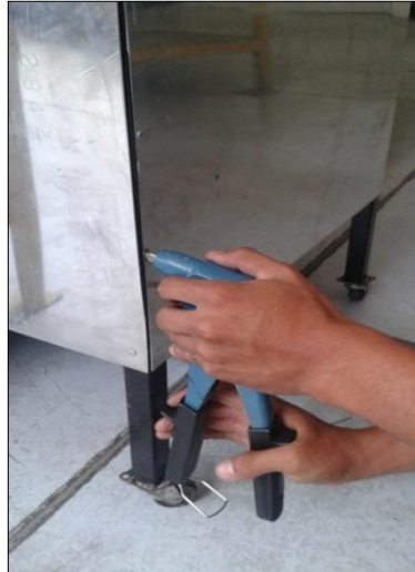
Figura 32 Remachada de la estructura metálica del banco de pruebas
