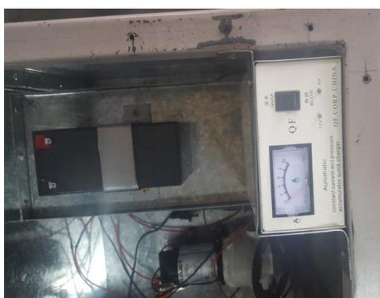
**Figura 83 Instalación de la batería**
