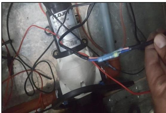
**Figura 87 Instalación de los splice**
