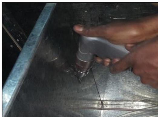
**Figura 84 Perforación para el paso de la tubería**
