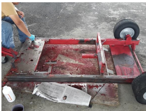
Figura 18 Remoción de Pintura
