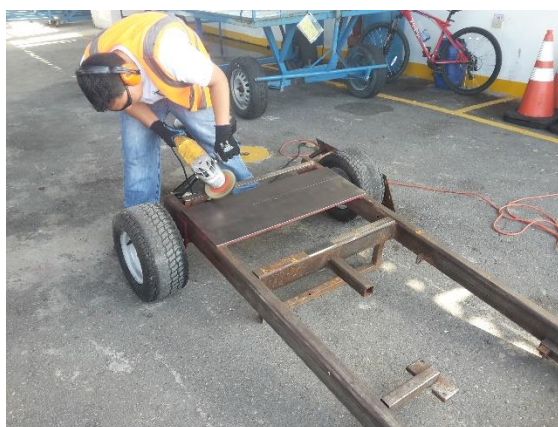
Figura 20 Remoción de Corrosión
