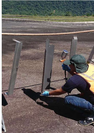
Figura 25 Pintura de Protectores
