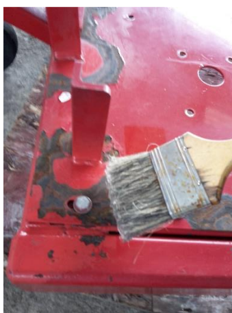
Figura 17 Aplicación de Removedor
