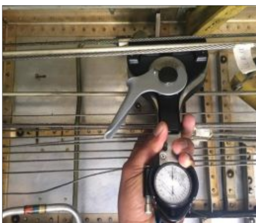
Figura 43 Medición de tensión en los cables.
