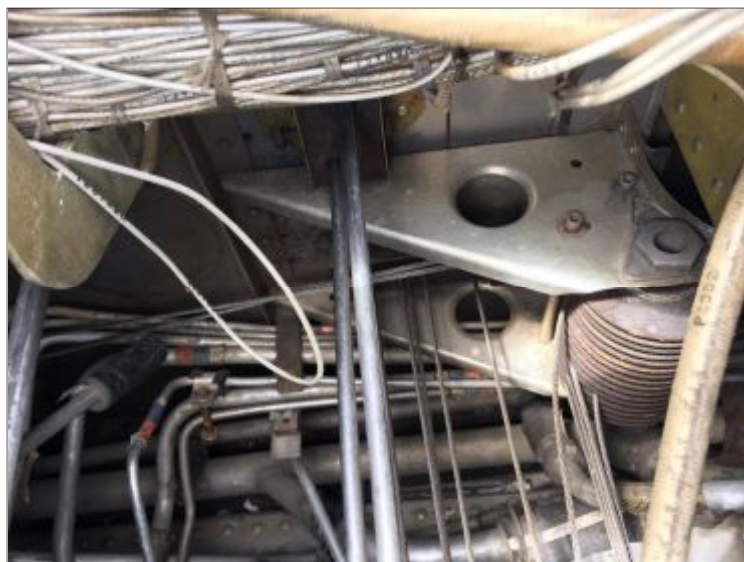
Figura 47 Inspección visual de cables.
