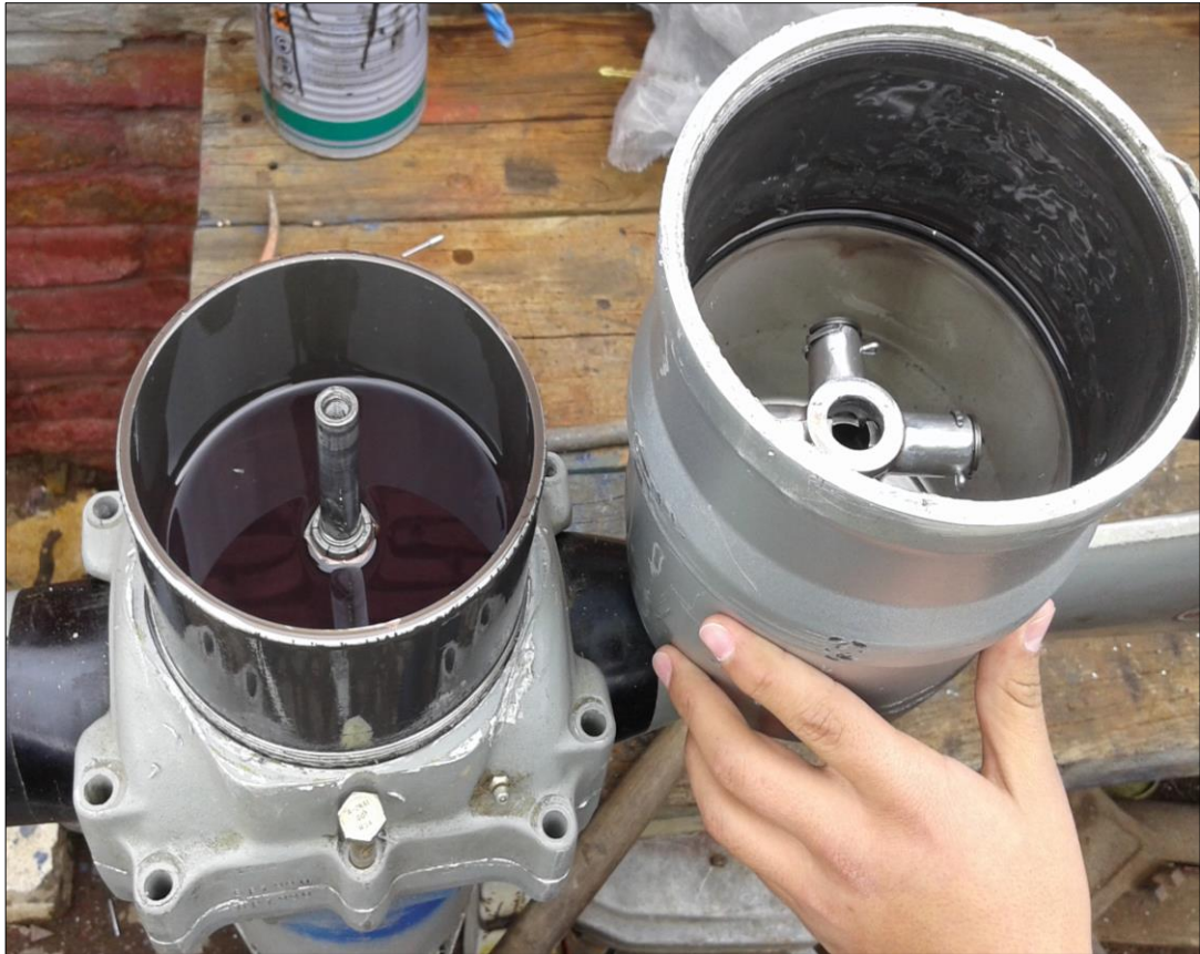
Figura 16 Desmontaje del cilindro
