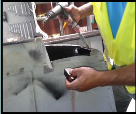
Reparación tipo parche
