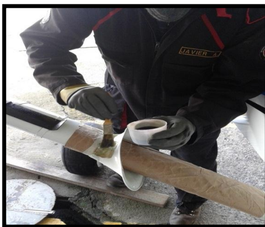
Figura 55 Aplicación de resina.
