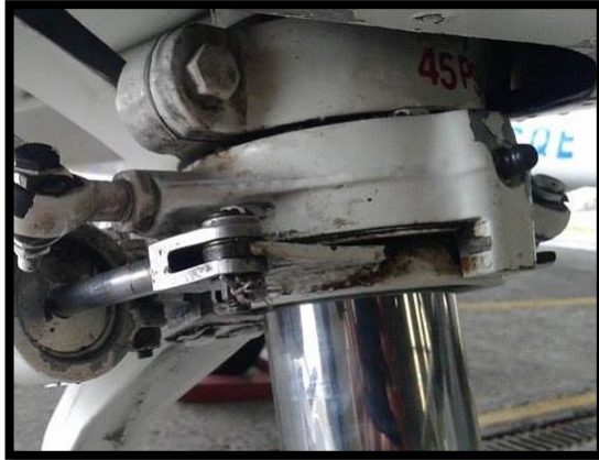
Figura 82 Montaje tren de nariz.
