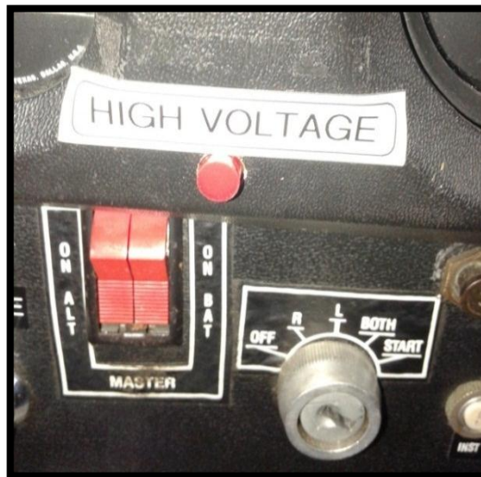
Figura 34 Indicaciones de alto voltaje.
