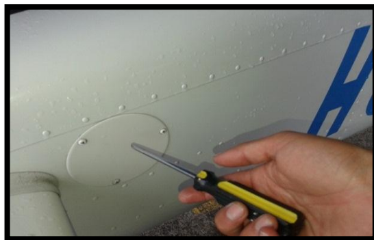
Figura 61 Tapa de inspección de fuselaje.
