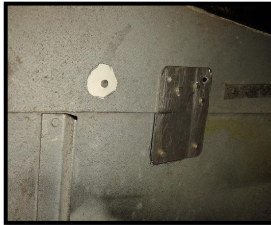
Figura 110 Reparación tipo parche.
