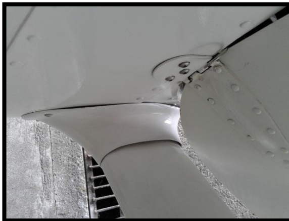
Figura 59 Finalización de la reparación.
