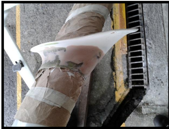
Figura 57 Aplicación de masilla.
