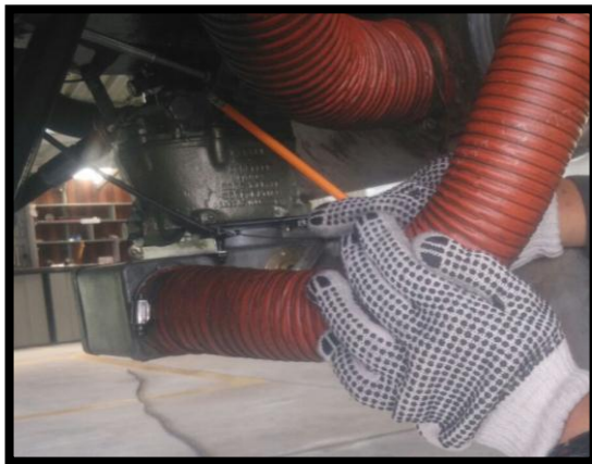
Figura 113 Control del acelerador.
