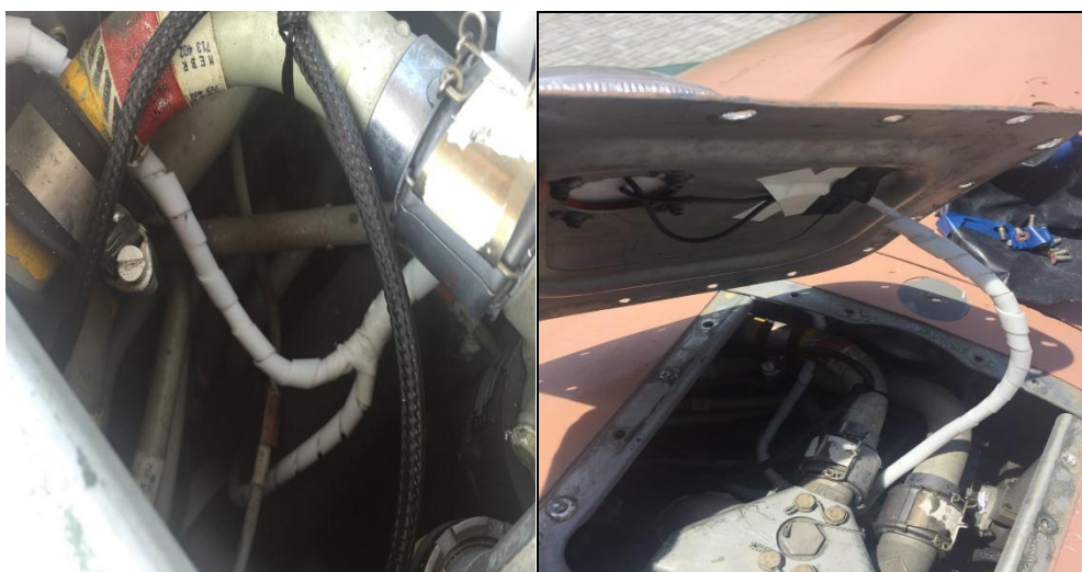
Figura 33 Ruteado del nuevo arnés eléctrico de la luz estroboscópica
