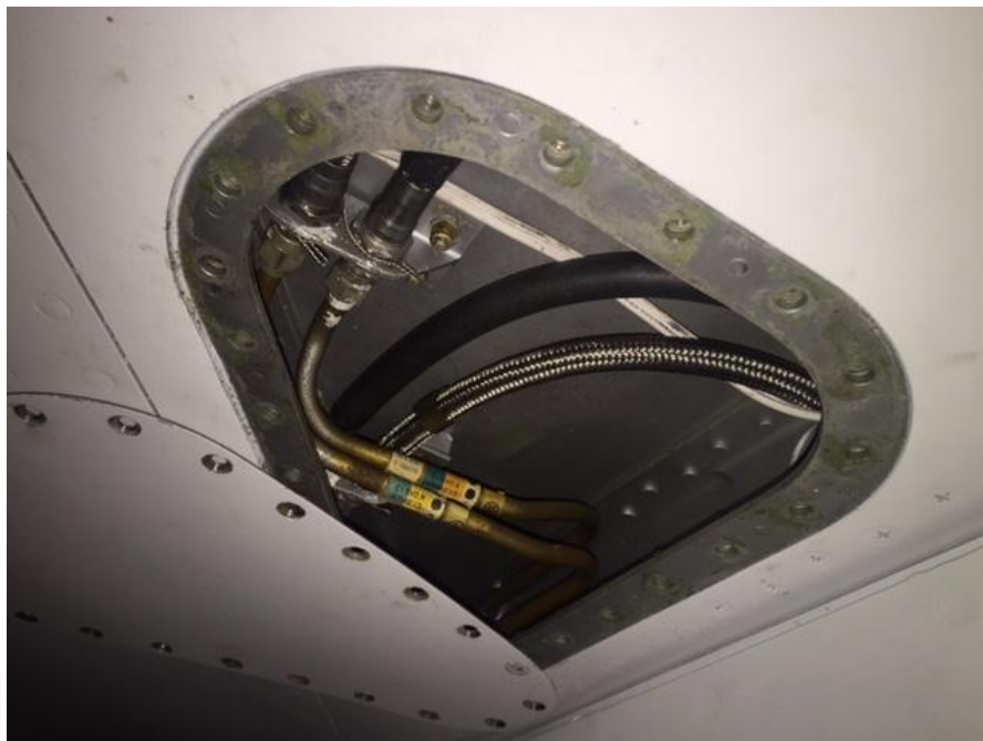
Figura 18 Panel de acceso de las luces de navegación
