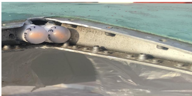
Figura 30 Instalación de los focos led G9- 2.4 W ,120-127 V en el estabilizador vertical
