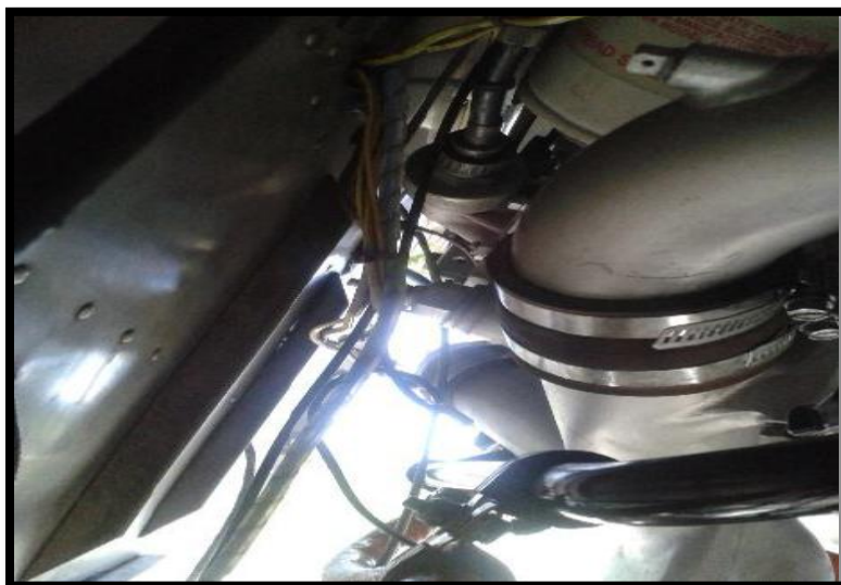
Figura 52. Instalación del indicador del tacómetro
