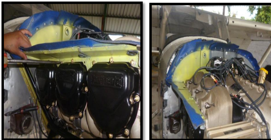
Figura 66. Instalación de los baffles o deflectores
