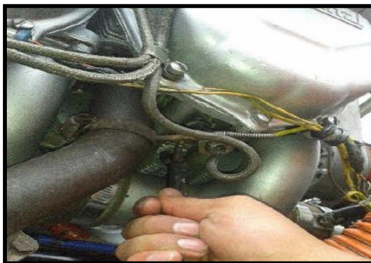
Figura 53. Instalación del bulbo del CHT
