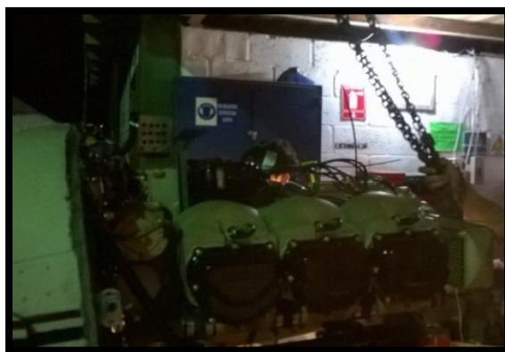
Figura 48. Montaje del motor
