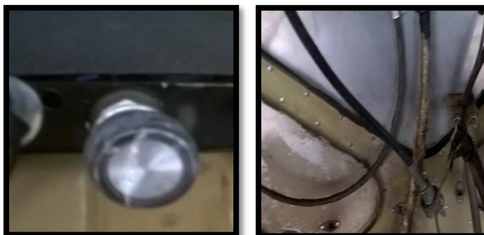
Figura 49. Instalación del cable del control de potencia
