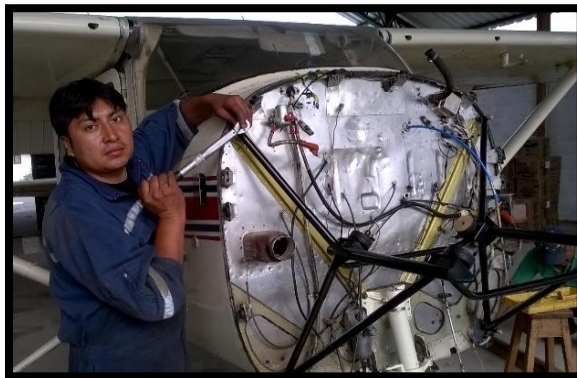
Figura 47. Instalación del castillo
