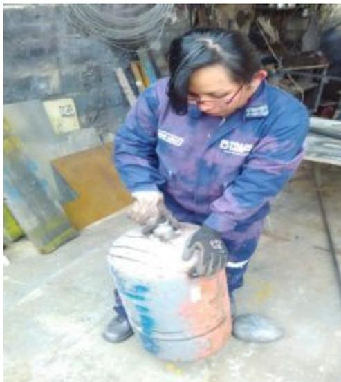
**Figura 17:** Instalación del punto de salida de arena
