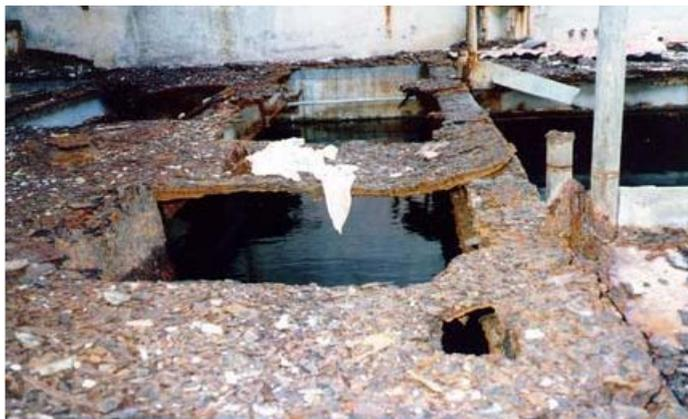
**Figura 3:** Corrosión uniforme
