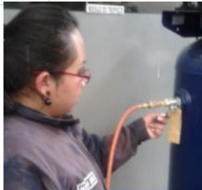
h. Verificar que el manómetro de presión ubicado sobre el filtro de aire marque entre 60 - 100 PSI.
