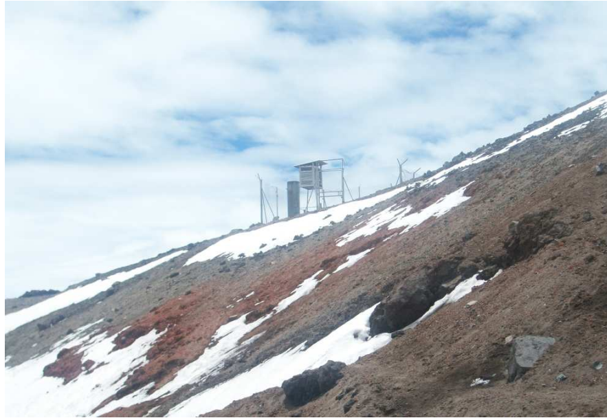
Figura 3.32. Sitio donde se efectuará el despliegue
