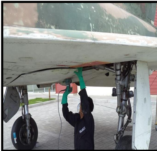
Figura 42 Decapado de la parte inferior del fuselaje
