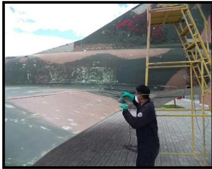
Figura 43 Decapado del flap del ala izquierda
