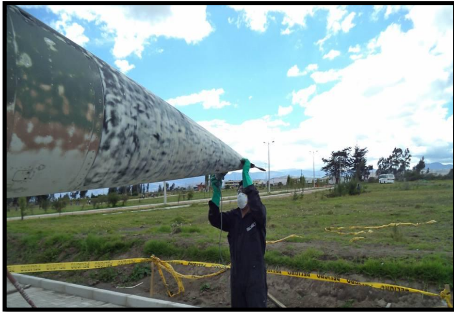
Figura 49 Decapado del radome
