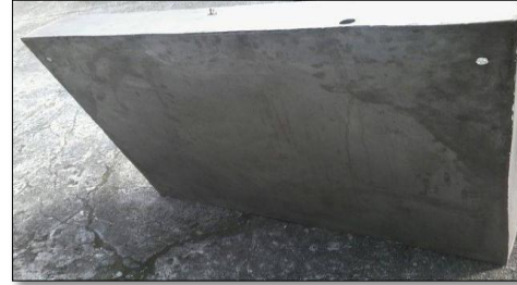
Capado de la caja reservorio
