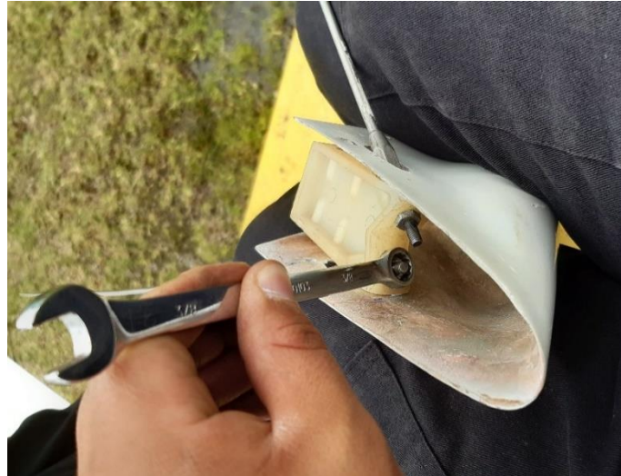
Figura 36. Instalación y ajuste de los dipolos de la antena VOR
