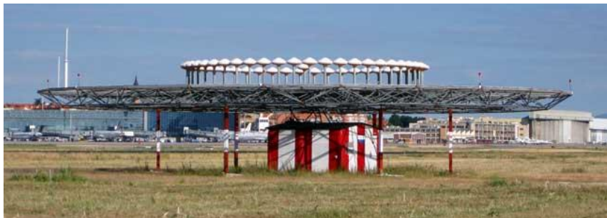
Figura 7. Estación VOR en tierra.
