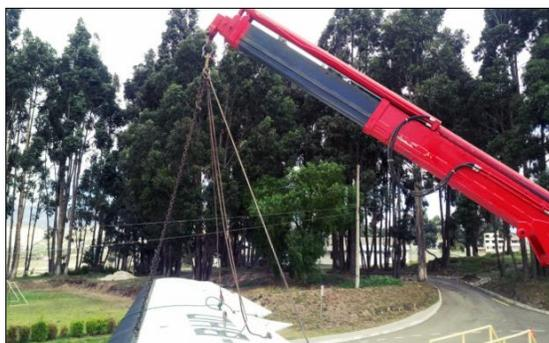
*Figura 53.* Colocación de la eslinga en la Grúa
