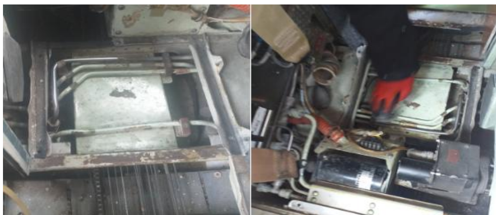
Figura 18. Inspección, limpieza de cañerías sistema pitot y estática
