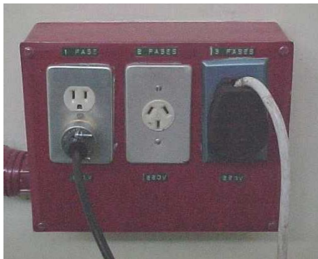
Figura 2.1. Caja de tomacorrientes al banco
