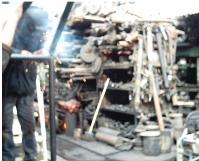
FIGURA D2. SUELDA DE LA ESTRUCTURA
