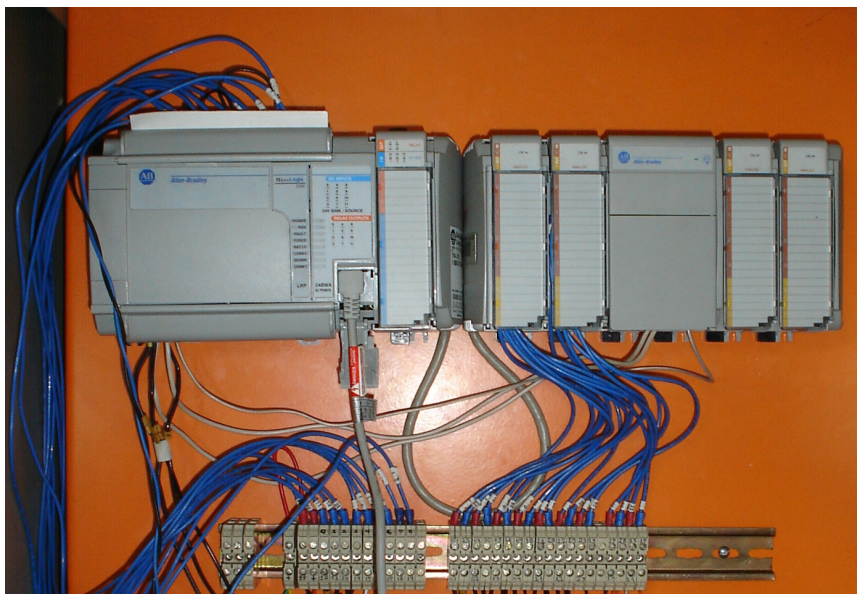
Figura. 3.11. Orientación del equipo instalado
