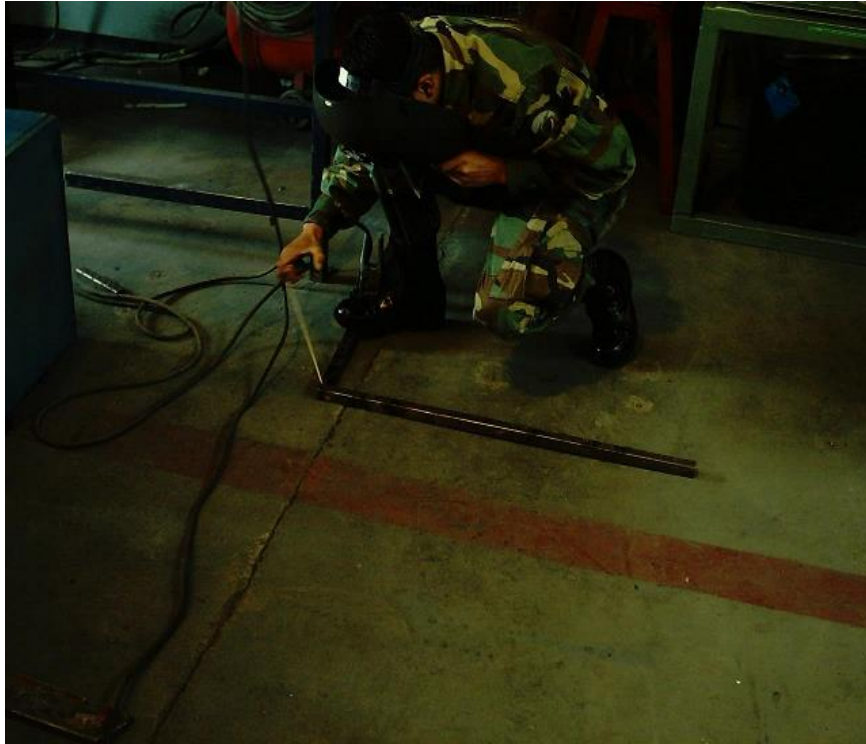
5.- Soldado de los tubos cuadrados de la mesa.
