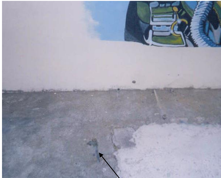
Fotografía No. 3.11 Tuberías empotradas y selladas del sistema de enfriamiento en el exterior del bloque 41
