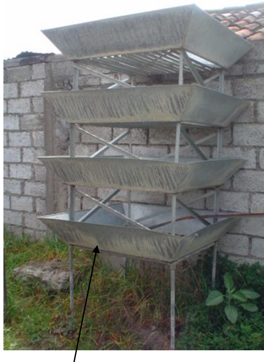
Fotografía No. 3.8 Torre de enfriamiento en la zona de containers
