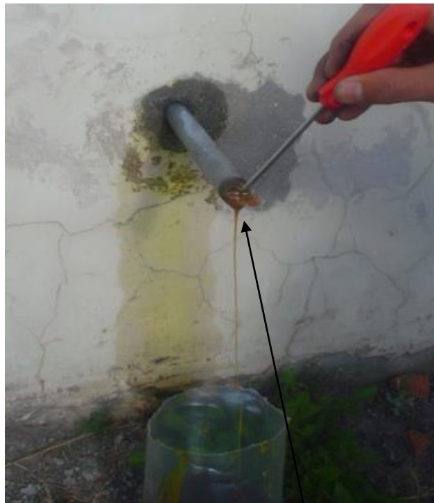
Fotografía No. 3.16 Tubería de drenaje exterior.
