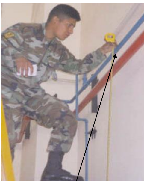
Fotografía No. 3.19 Medición de alturas de la red neumática.
