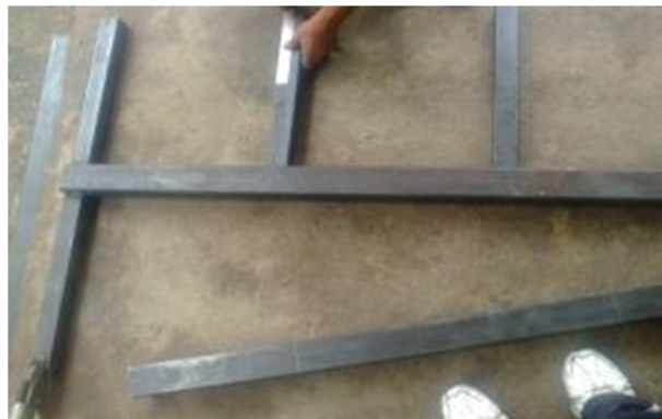
Figura 3. 13: medición de la base estructural tubo cuadrado de 50 x 50 mm y 3 mm de espesor
