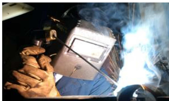
Figura 2. 38: Soldadura de arco
