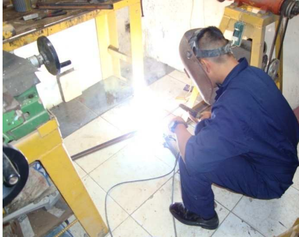
Figura 3.2 Soldadura de los ángulos para la estructura.
